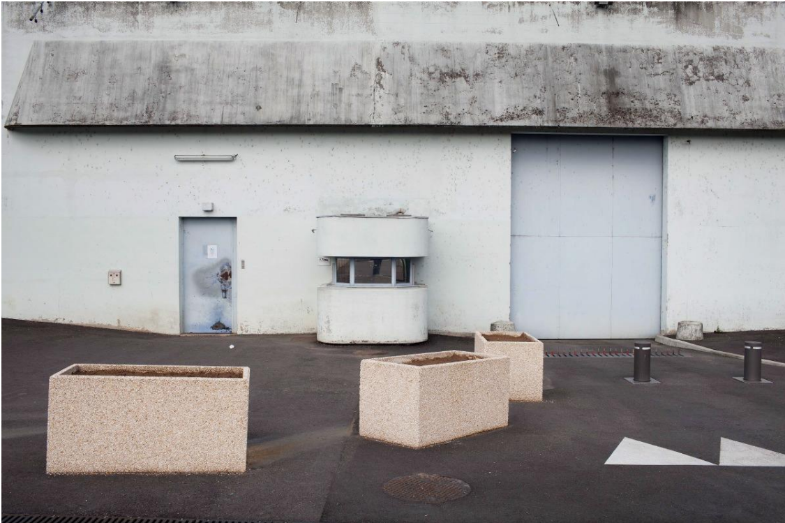
Porte d'entrée principale de la maison centrale
